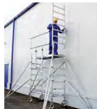
Sécurisée par le garde-corps "de tête", la plateforme est accessible sans danger et le montage de l'échafaudage peut être poursuivi. Le garde-corps de sécurité de montage est à nouveau placé "en tête" pour les plates-formes suivantes avant de monter au niveau supérieur.
